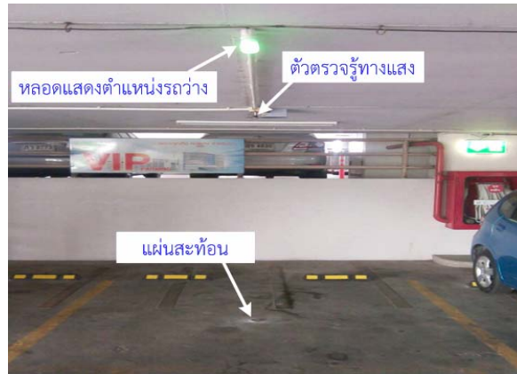
การติดตั้งตัวตรวจรู้ทางแสงและการติดตั้งแผ่นสะท้อนที่พื้นลานจอดรถ
